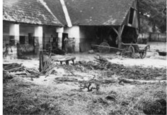
Bild 2: Verschlammung im Haus v. Karl Tagwerker, Hauptstr. 45
