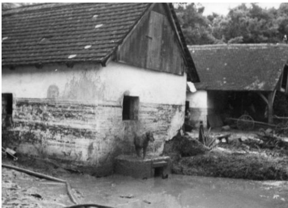
Bild 3: Hof mit Wassermarke v. Hochwasser auf Hauptstraße 45
